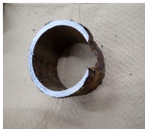
腐食により減肉した状況（配管断面）
