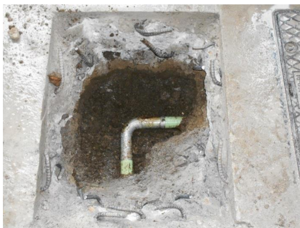
埋設配管の掘削状況
