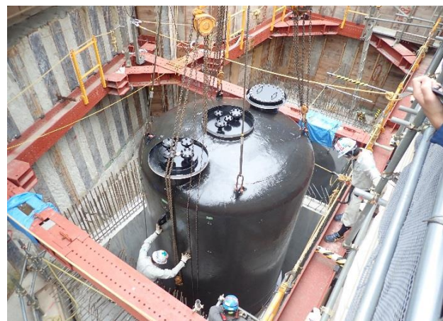
工事中の縦置円筒型地下タンク貯蔵所
