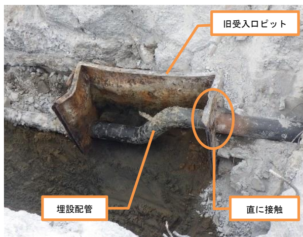
埋設配管と旧受入口ピットの状況
