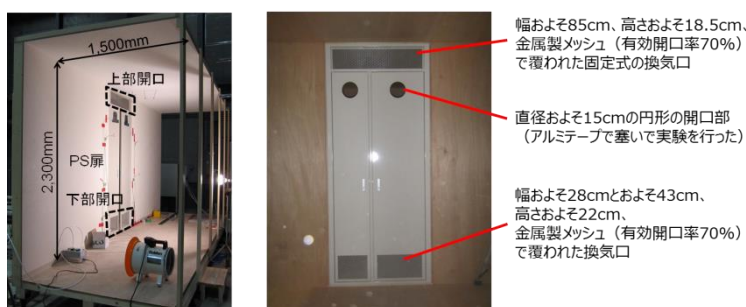
図 2.2.3-2 パイプシャフト設置状況
